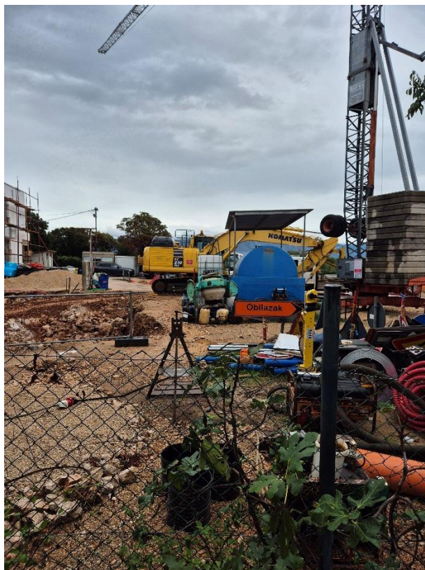
Slika 5: Građevinski radovi u neposrednoj blizini mjerne postaje
