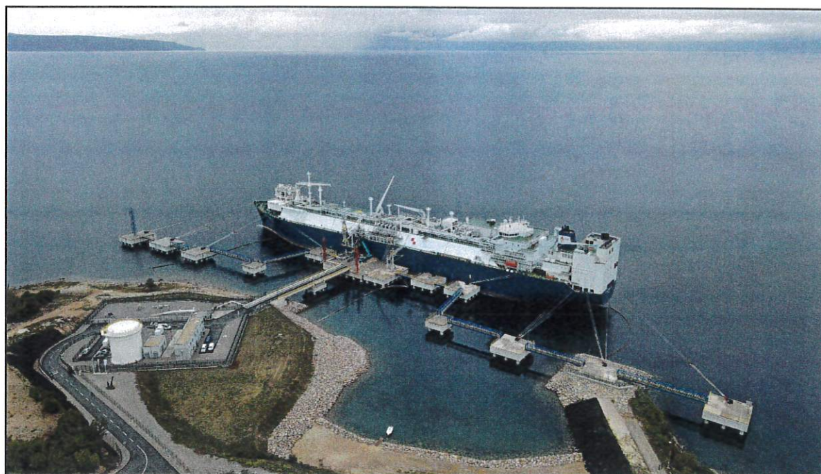
Figure 2. 1. LNG Terminal Krk
