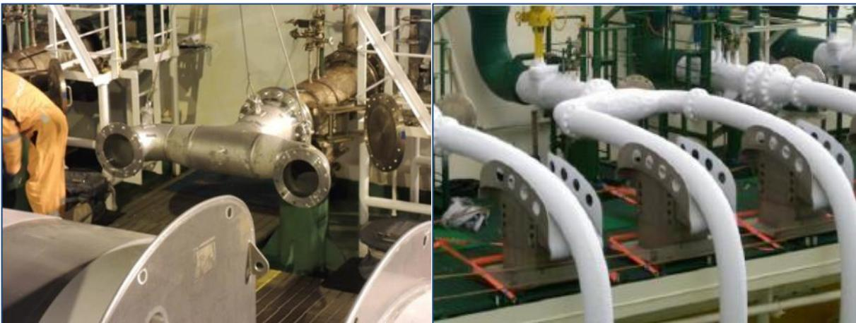
Slika 26 Postavljanje reduksijskih spojeva
